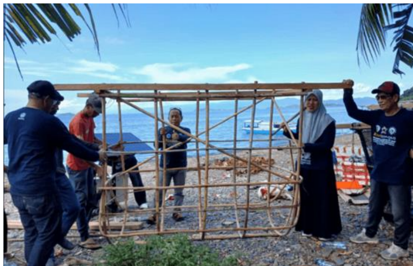
Gambar 3. Perakitan rangka kalase (ruang tengah tempat penjaringan ikan)
