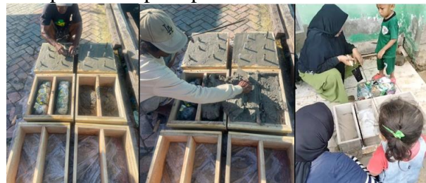
Gambar 8. Proses Pembuatan Media Transplantasi Berbahan Tambahan Sampah Plastik yaitu memasukkan campuran beton ke dalam cetakan yang terdiri atas pasir, semen dan air dengan perbandingan 3:1:4 sampai 4:1:5 ke dalam cetakan setebal 5 cm
