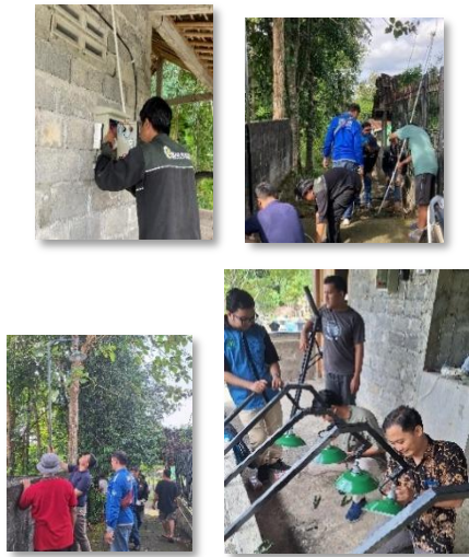
Gambar 18. Proses Pemasangan Instalasi Penerangan Jalan
