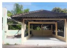
Gambar 8. Tampilan Balai RT sisi Kanan yang telah dilakukan revitalisasi
