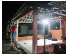
Gambar 7. Proses Perbaikan dan Pengecatan Balai RT
