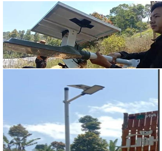
Gambar 6 Perakitan dan pemasangan Solar Cell
