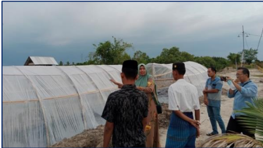
Gambar 2. Sungkup sebagai tempat pembuatan garam dari air laut
